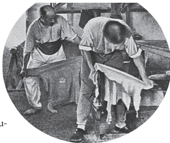
Lavoratori che utilizzano il palissone fisso
